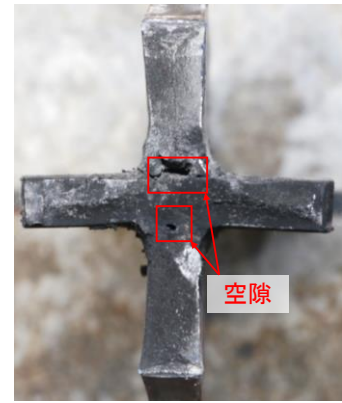
図8 溶接部の空隙（試験体7）
